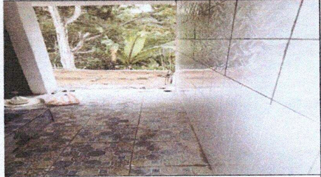
Foto 2: Reparación de piso de torta de cemento, 60 metros cuadrados
