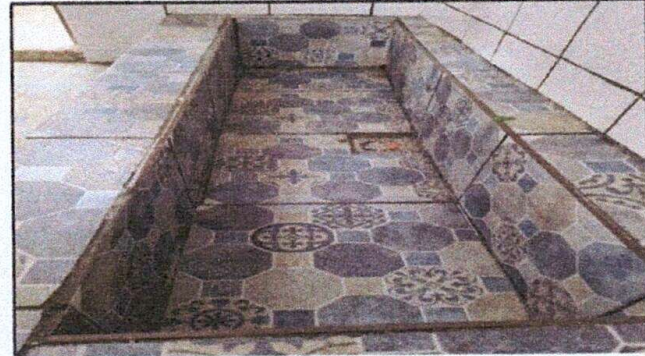
Foto 4: Instalación de llave de paso
