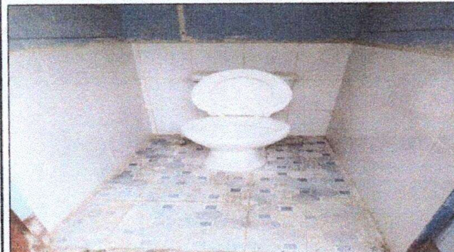
Foto 3: Sustitución de letrina de cemento e instalación de inodoro y accesorios.
